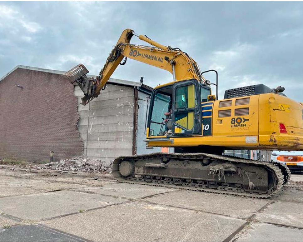
Boy Limmen demonteert loods aan de Edisonweg in Alkmaar.
