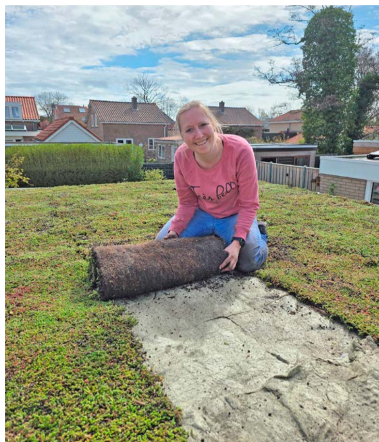
Renske die haar sedumdak aanlegt in de Heemradenwijk in Heerhugowaard. Foto: aangeleverd
